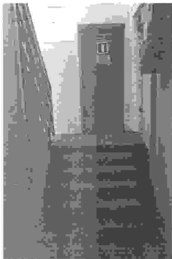
Фото №7 Лестница (внутри здания)
