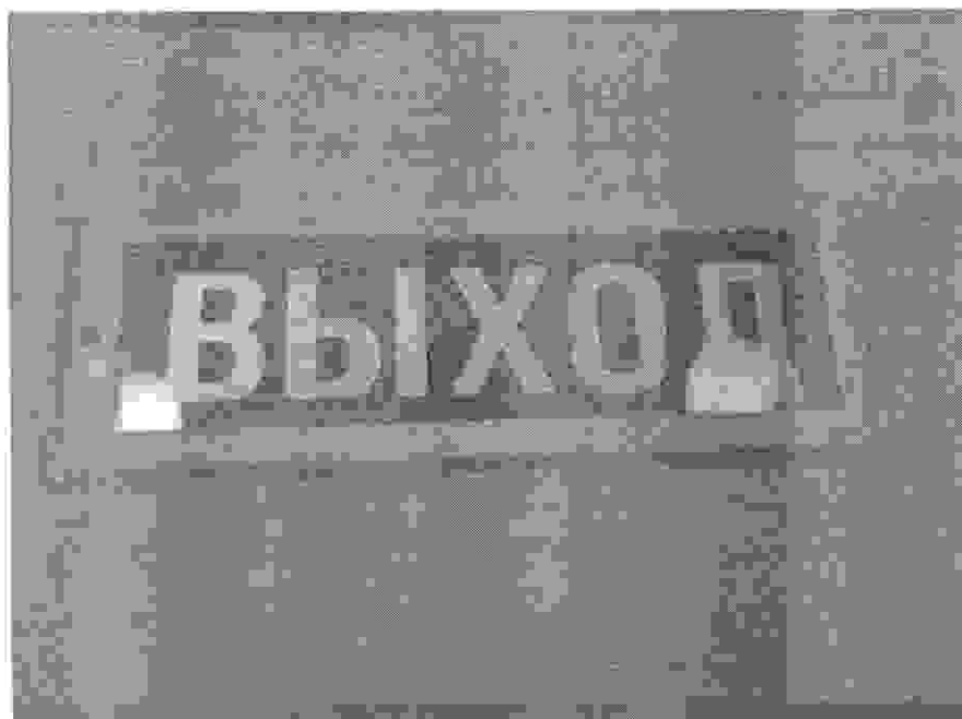
Фото №14 Визуальные средства путей эвакуации
